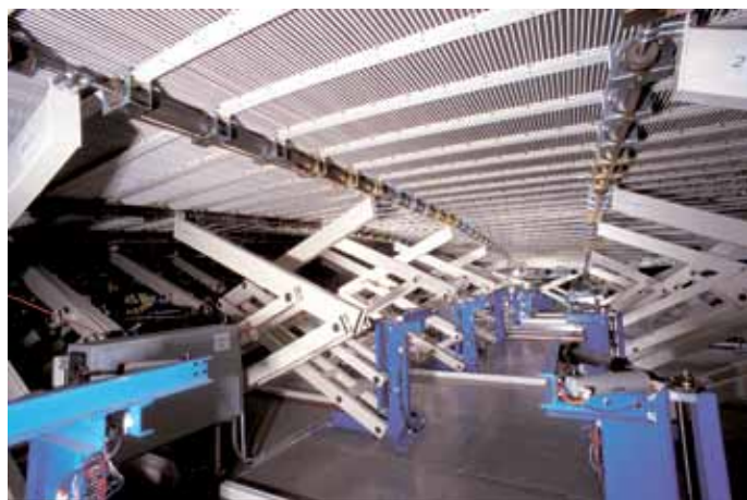
Ένα σύγχρονο πρόγραμμα ηλεκτρονικού υπολογιστή διαβάζει το σχέδιο και στην συνέχεια καθοδηγεί την διάρθρωση του καλουπιού. Στην φωτογραφία φαίνεται το κάτω μέρος του καλουπιού το οποίο και διαμορφώνουν σύγχρονοι μηχανισμοί κίνησης.
